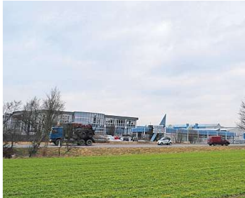
An der B 15 hinter der Firma Sommer entsteht neues Gewerbegebiet. Foto: Langer
